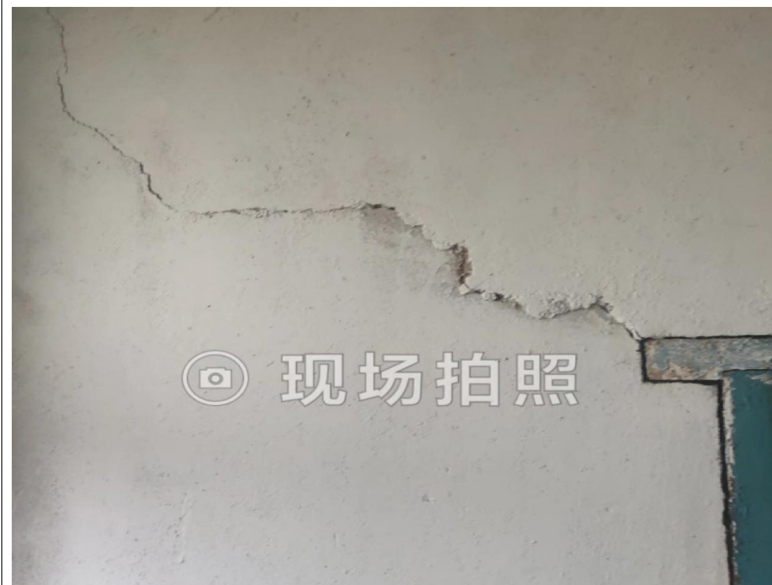
图版 3-17 T7 塌陷区现状
