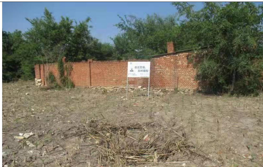
图版 3-8 T2 塌陷区现状
