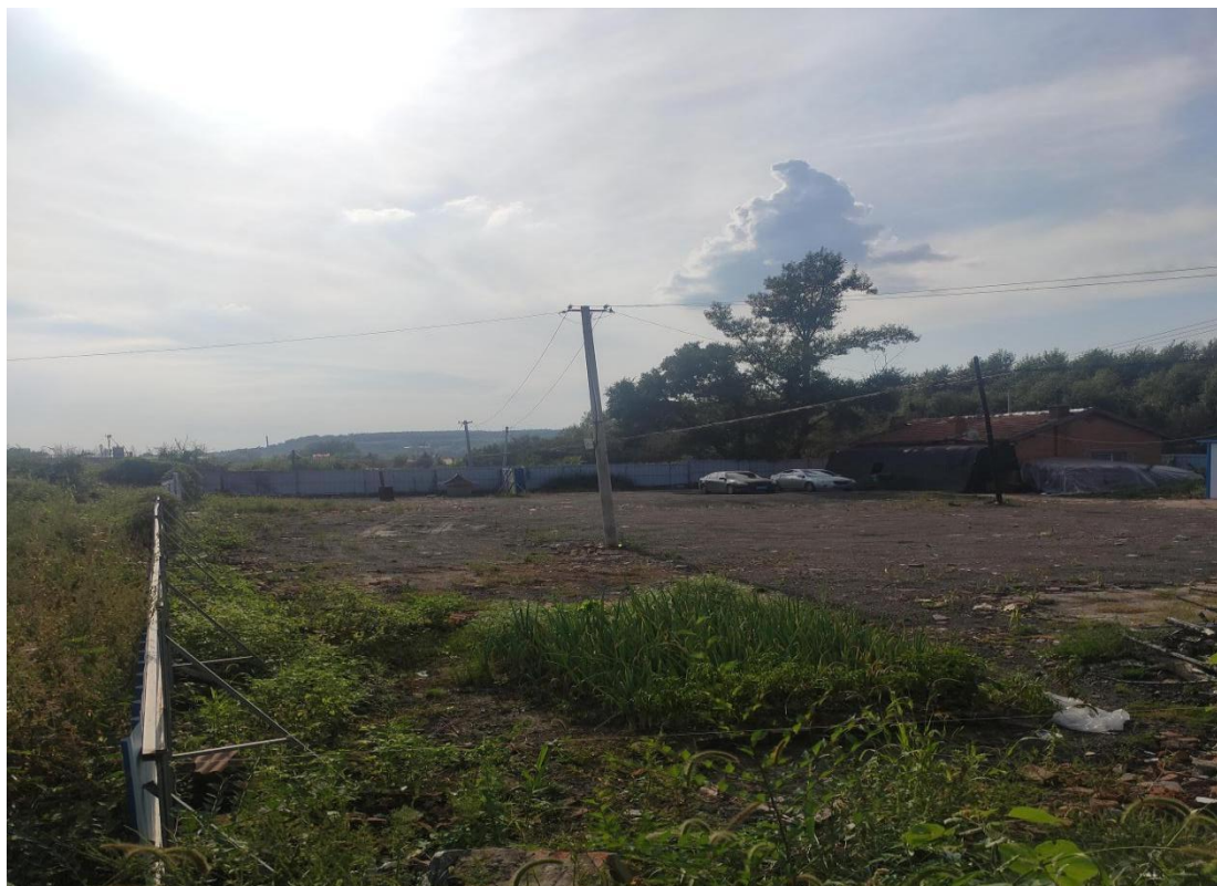
图版 3-6 T1 塌陷区现状
