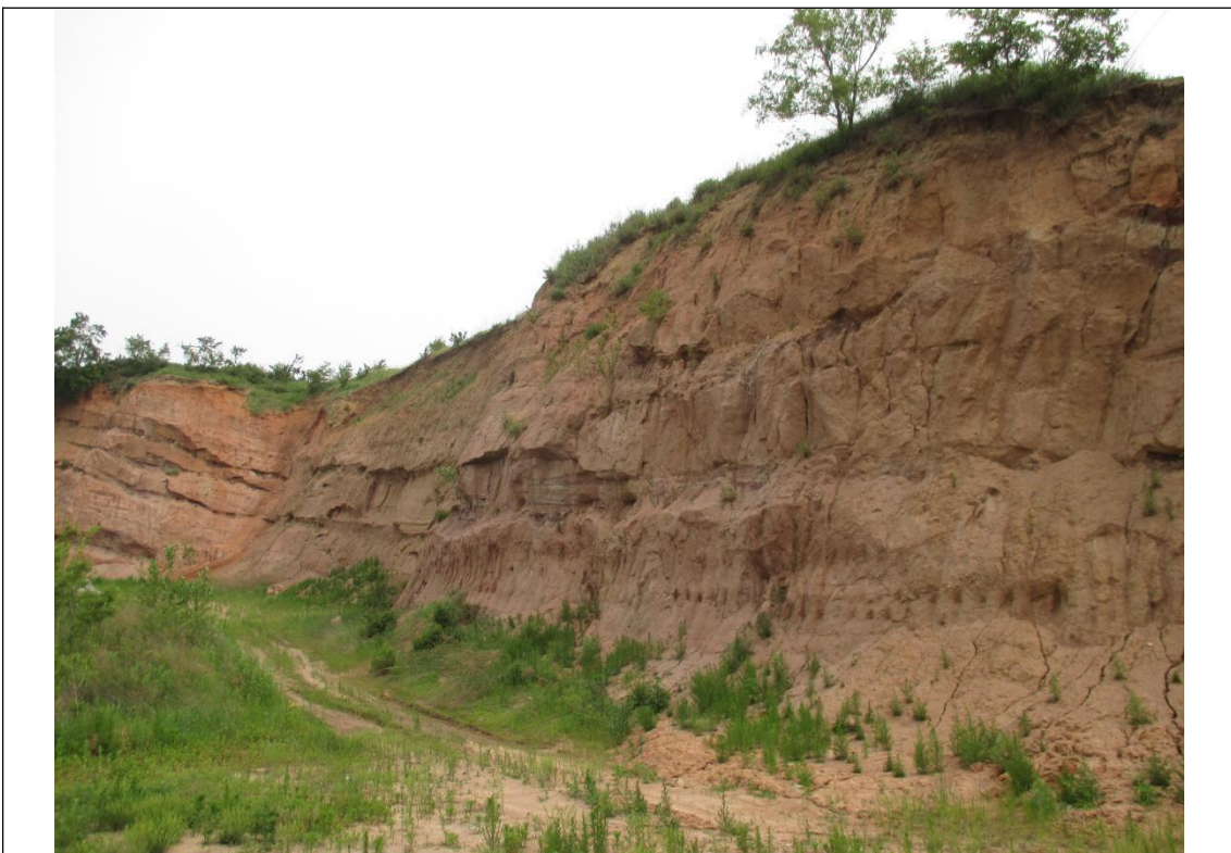
图版 3-4 B2 崩塌地质灾害现状
