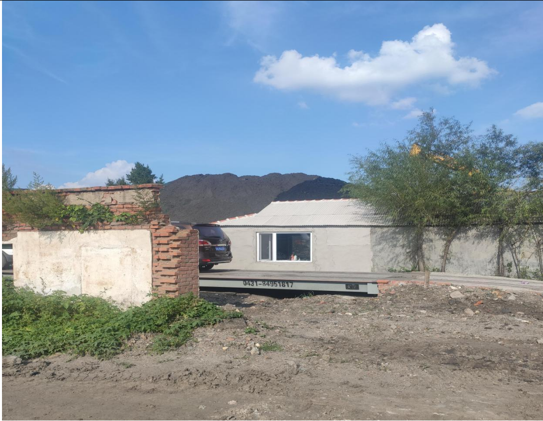
图版 3-5 T1 塌陷区现状
