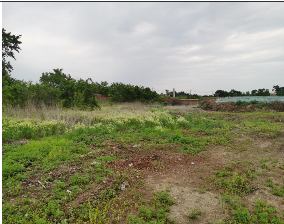
图版 3-12 T4 塌陷区现状
